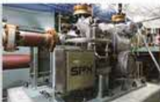
高圧原子炉代替注水ポンプ
