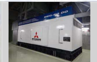
ガスタービン発電機
