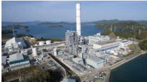
実証試験設備の様子
