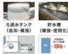
常設代替注水設備(水槽)
