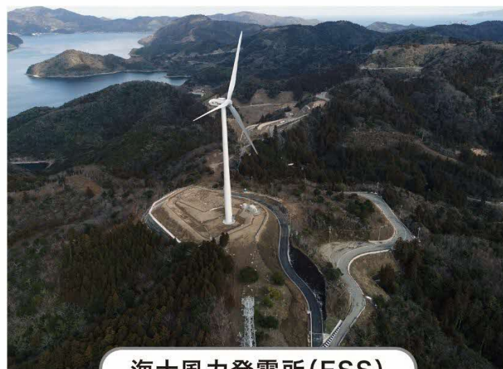
海士風力発電所(ESS)
