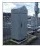
避難経路等に設置
