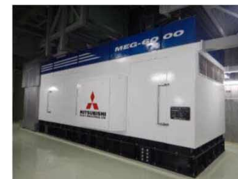
ガスタービン発電機
