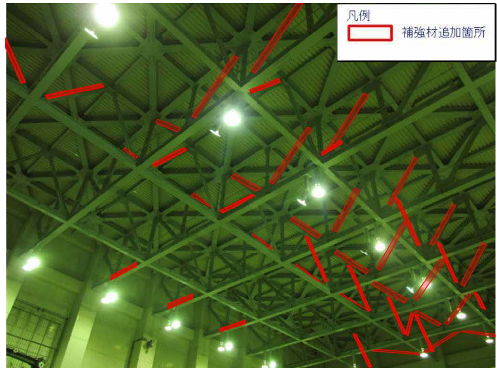
原子炉建物耐震補強工事状況
