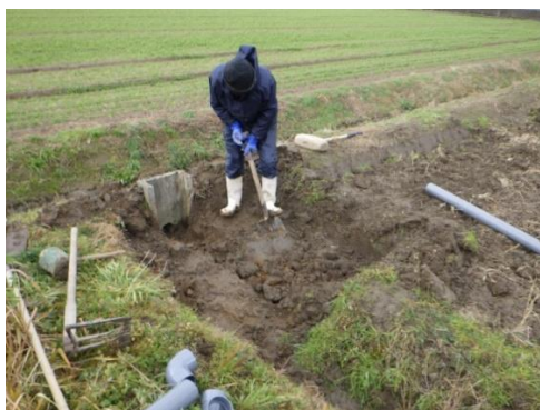
▲水田の排水口付近に整備する
