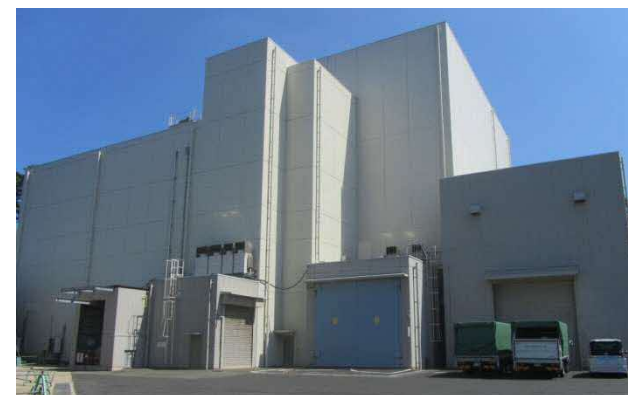
サイトバンカ建物外観
