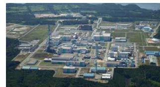
再処理工場 2022年度上期竣工予定
