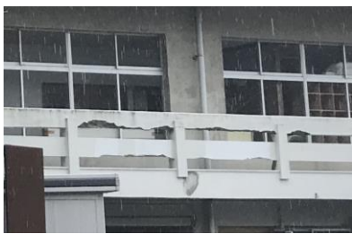
劣化状況（拡大）
