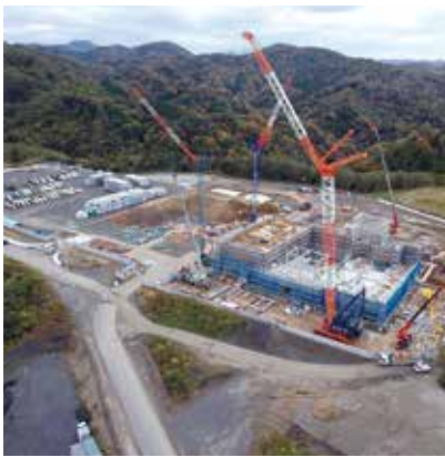
【施設建設工事現場】
