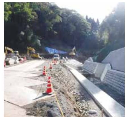
【アクセス道路工事(2工区)の様子】
