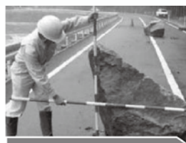
③ 現場確認
