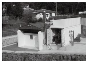
佐田町にある須佐温泉ゆかり館では、木質チップボイラーを導入しています。ボイラーの燃料は重油や灯油が一般的ですが、ここでは木質チップ(木材を機械で碎きチップ化したもの)が燃焼する際に発生する熱を利用して温泉の温度調整を行います。
