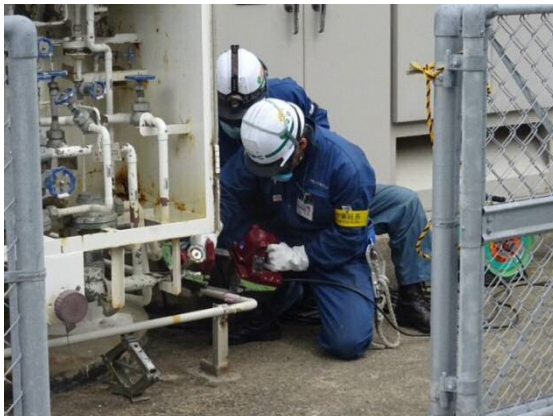
放射性物質による汚染のない設備の解体撤去 (配管の切断)
