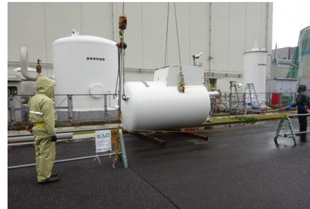
放射性物質による汚染のない設備の解体撤去 (タンクの吊り上げ)
