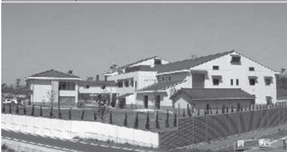
図 2-1-2 出雲環境センター外観
