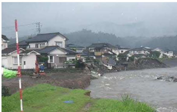
河岸侵食による家屋の倒壊(花月川)
