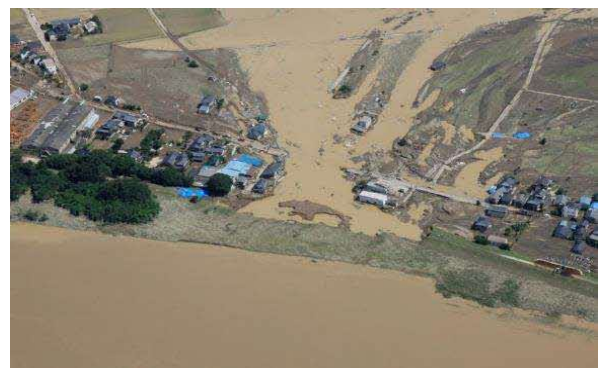
堤防決壊による家屋の流失(鬼怒川)
