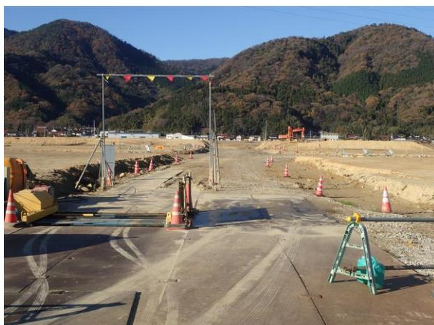
③敷地南側のダンプの搬入路です。ここも左右と同じ高さまで土を盛ります。手前左側にある機械はダンプのタイヤに着いた泥を落とす機械です。
