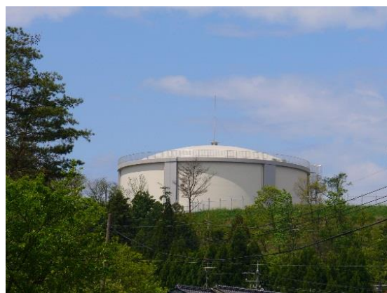
新向山配水池 (容量 7,000 m 3 )
