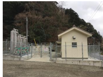
美保塩津浄水場
