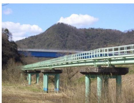
岩棚池水管橋（導水管）
