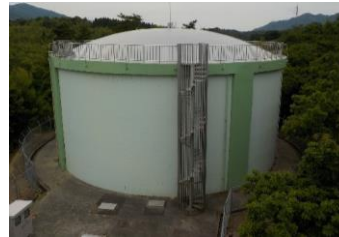
愛宕山配水池
