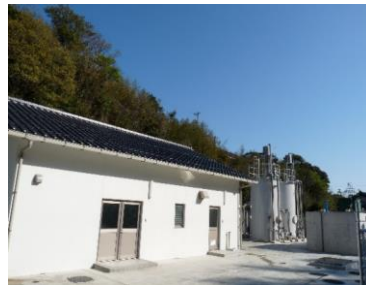
日御碕浄水場
