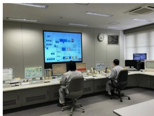
来原浄水場中央監視室
