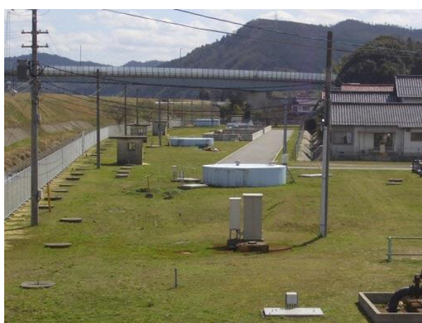
来原水源地取水井
