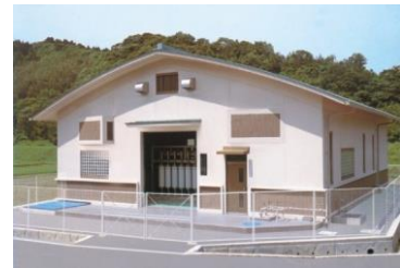
多伎膜処理施設棟
