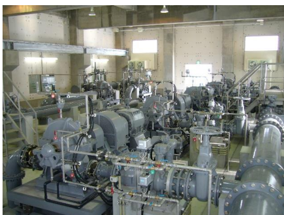
来原浄水場送水ポンプ室
