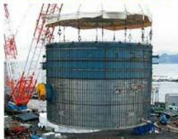
原子炉格納容器 下部鋼製ライナ大ブロック
