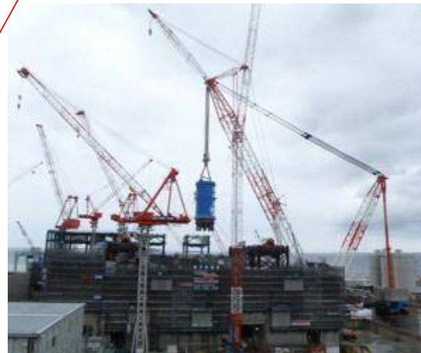
原子炉建物への吊込み
