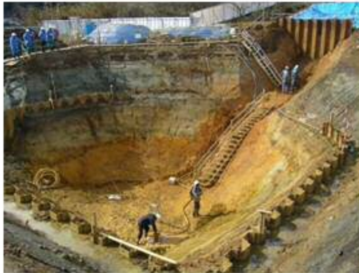
トレンチ調査状況
