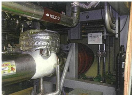
耐震補強工事前
