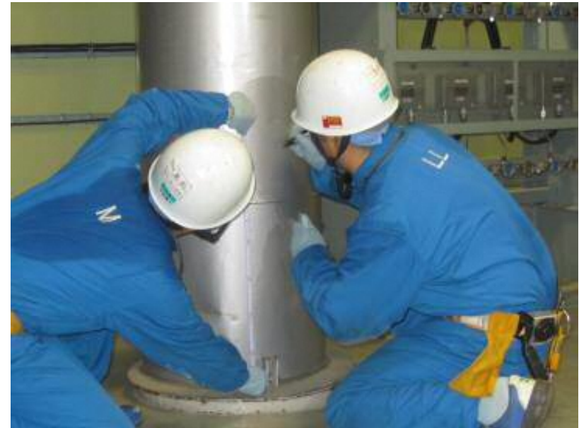
配管へのマーキング作業
