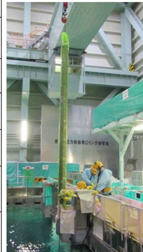
新燃料除染作業
