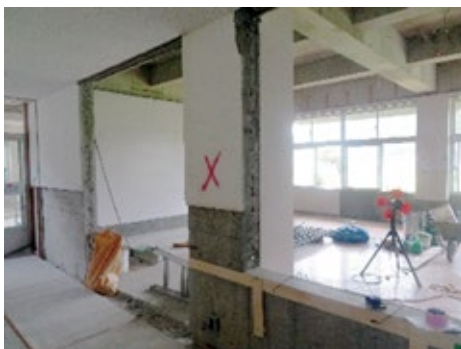
保健室を和室に改修中
