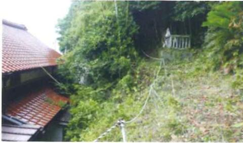
た。落石防止ネットの背後地は、擁壁、ストーンガードがあり、途中で寸断している箇所への落石の心配はない。
