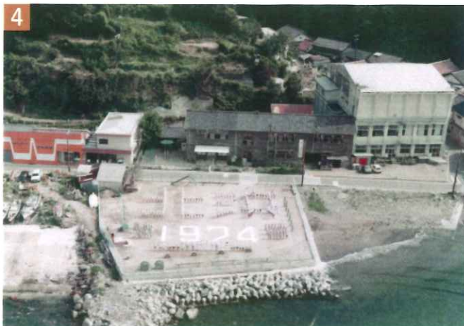
役場の仮校舎が鉄筋校舎になり、3階に体育館がありました。 た。
