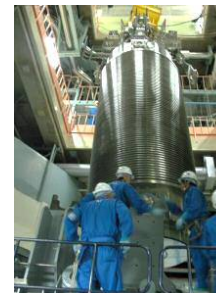
(写真1) 原子炉建物5階へ輸送容器吊り上げ
