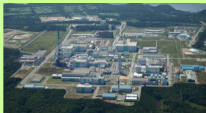
再処理工場全景※ (2018年度上期 竣工予定)
