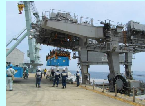
輸送船への吊り込み作業
