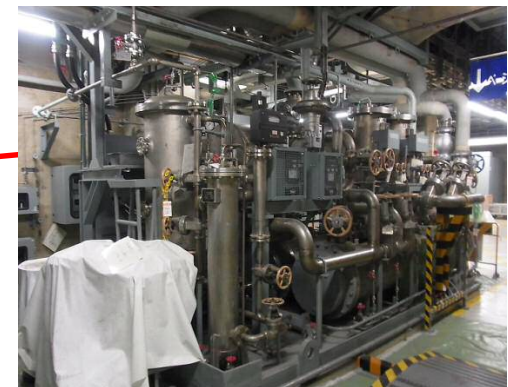
固定子冷却設備※
