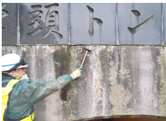
坑門のひび割れ・遊離石灰
