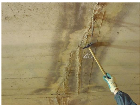
覆工（側壁）のひび割れ・遊離石灰
