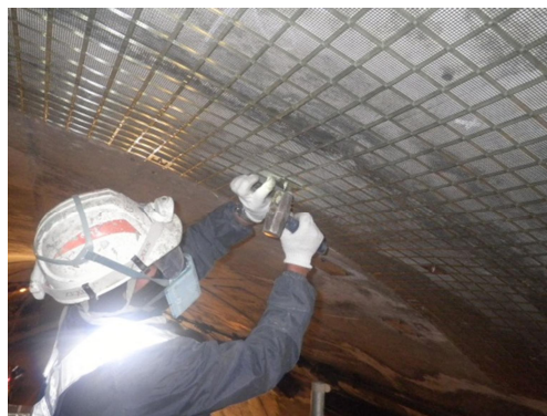
写真 3-1 FRP ネット設置状況
