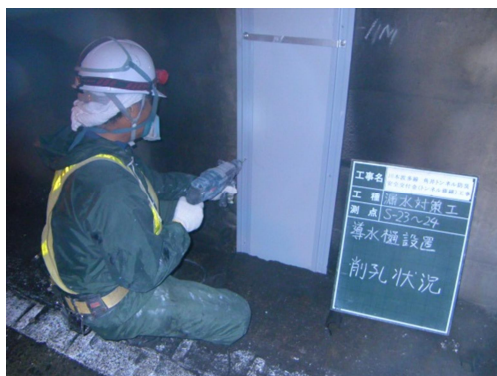
写真 3-2 線導水工
