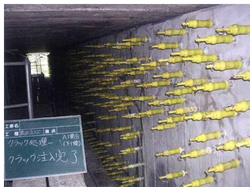
写真 4－2 ひび割れ注入状況
