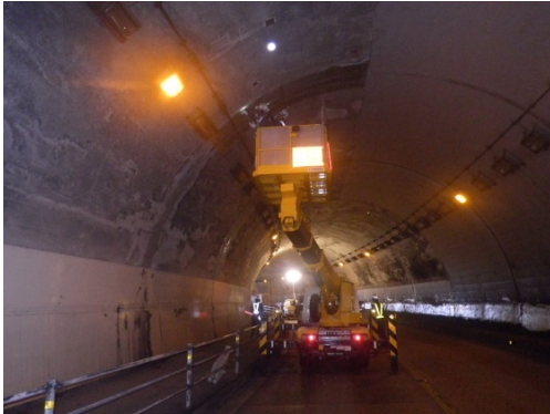
写真 3-1 FRP ネット設置状況
