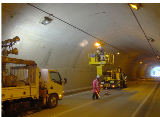
写真 2-1 トンネル点検状況
