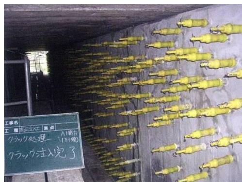
写真4-2 ひび割れ注入状況
