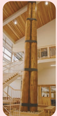
地元 吉栗山から伐り出されたスギの御柱
