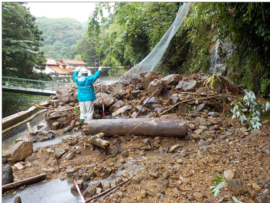
↑ 市道の斜面崩落（河下町）
