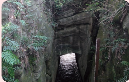
斐伊川から高瀬川・間府川への取水口である「来原岩樋」(大津町上来原地内)
