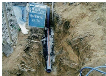
排水設備工事の状況
