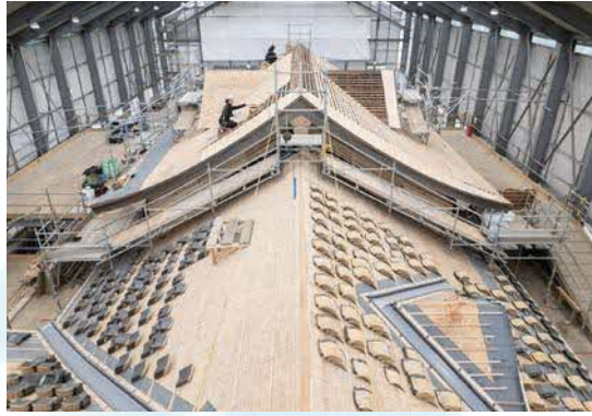
保存修理の現場の様子
