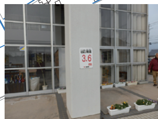
荒木コミセン、標高 3.6m 建物の高さとしては低い
