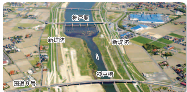
工事着工後(平成24年)河口から7Km付近
