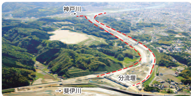
工事着工後(平成24年)斐伊川の分流地点から斐伊川放水路を望む
