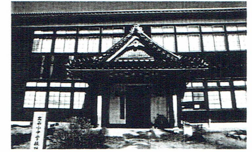
屋根の修復等が終わった斐川環境学習センター
