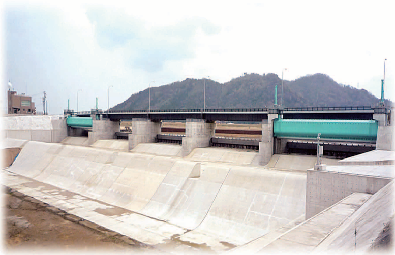
完成した斐伊川放水路分流堰—大津町上来原—
