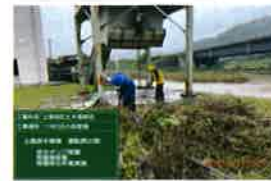
上島排水機場 除塵作業
