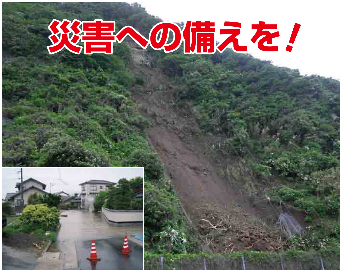
平成23年5月豪雨での被害の状況
