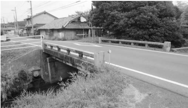
県道多伎江南出雲線の持田橋
