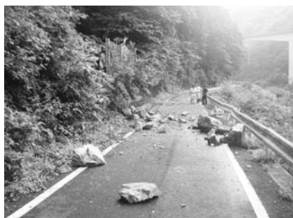
対策工事が必要な落石箇所
