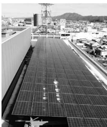
市役所屋上にある太陽光発電施設
