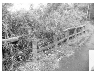
復旧が急がれる遊歩道の危険力所
