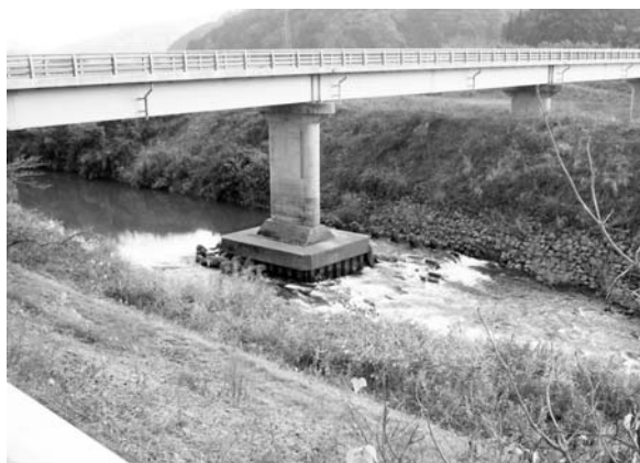
斐伊川河床低下による森坂大橋の洗掘状況
