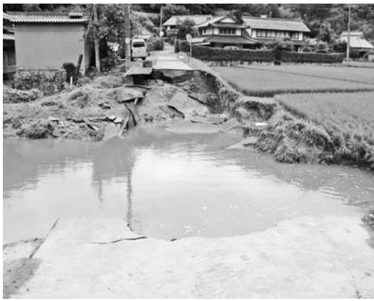
寸断されたライフライン（平成18年災害出雲市内）
