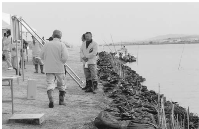
ヨシ原復元活動により整備された状況（出雲市斐川町黒目）
