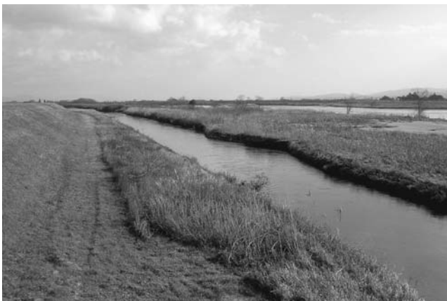
なまずの尾(生命の水)・舟川導水路
