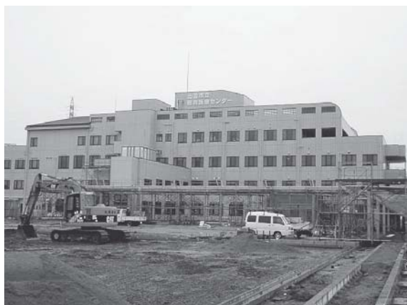
平成24年3月の完成に向けて工事が進む総合医療センター
