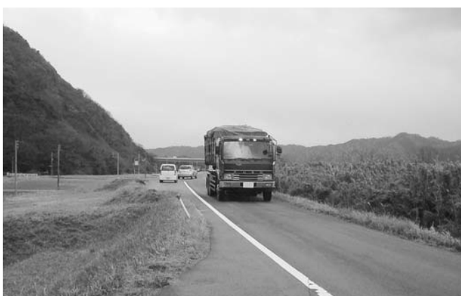
斐伊川堤防・上出西付近…早期拡幅を
