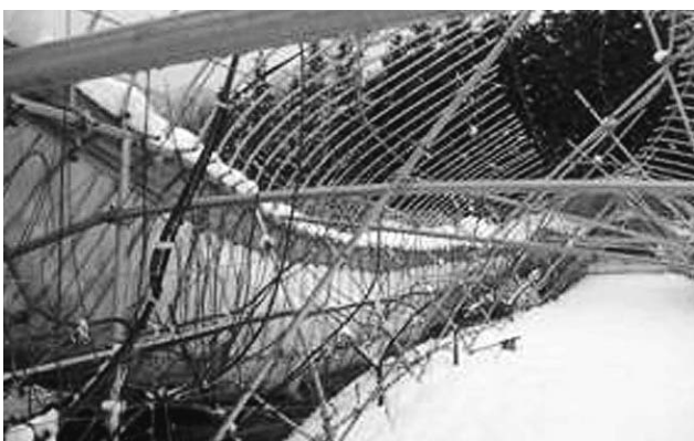
倒壊したブルーハウス
