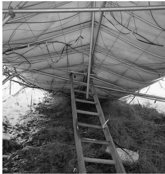
雪の重みで倒壊したビニールハウス（佐田町）
