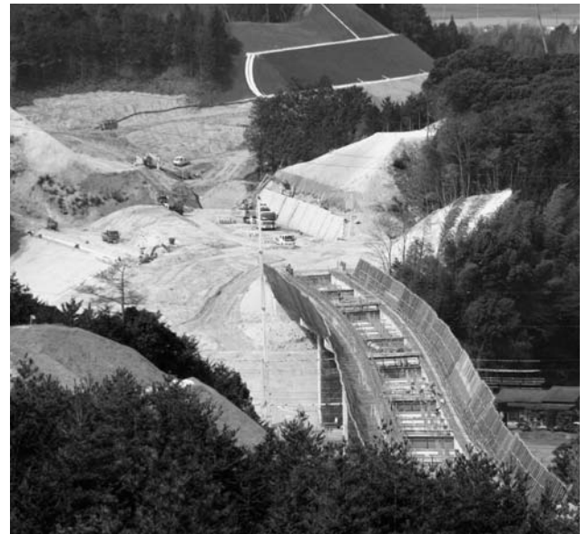
建設が進む山陰自動車道（出雲インターチェンジ付近）
