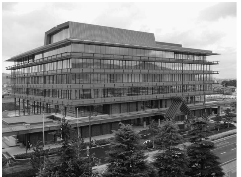
竣工した新庁舎
