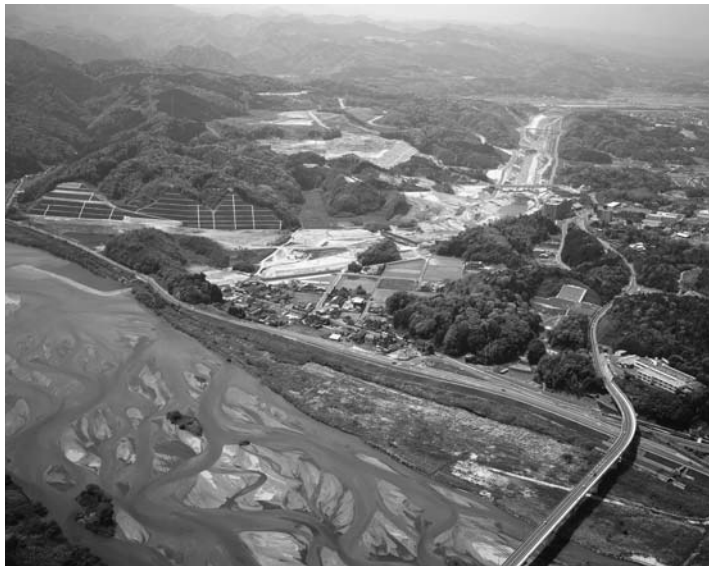
計画どおりに進む斐伊川放水路事業 (写真提供：国土交通省 中国地方整備局 出雲河川事務所)
