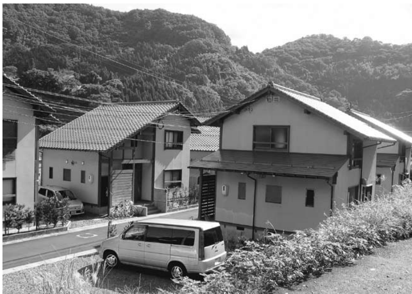
定住につながる公営の一戸建て住宅（佐田町大呂・八幡住宅）
