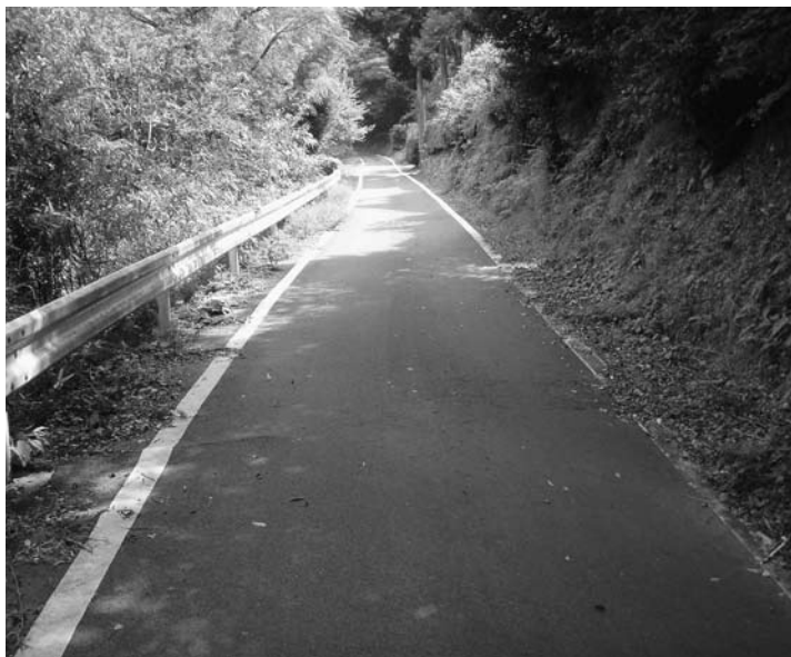
山間地域の狭い道路（三津町）
