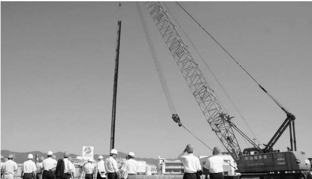
鋼矢板の打込み作業が続く新庁舎建設予定地
