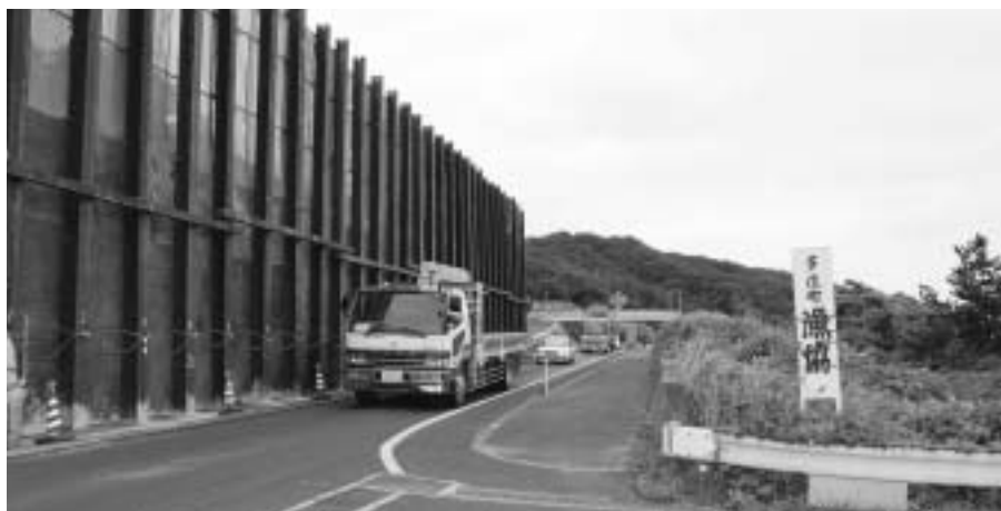
豪雨災害で寸断された国道9号(多伎町)
