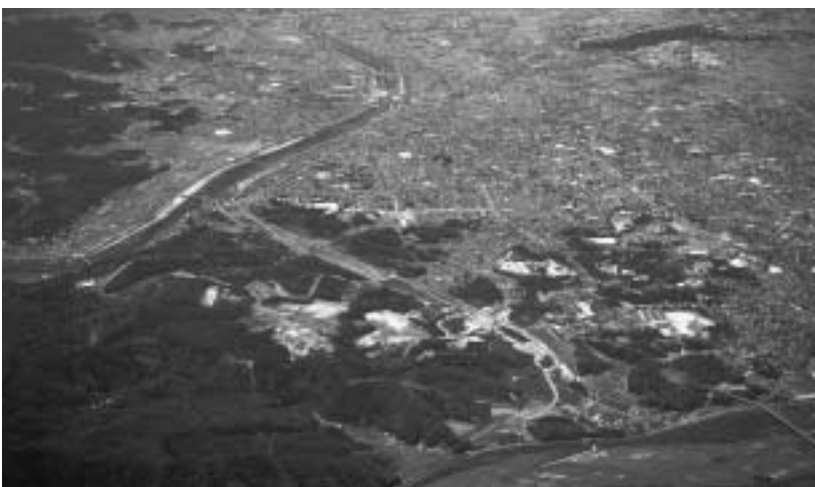
工事が進む斐伊川放水路事業
