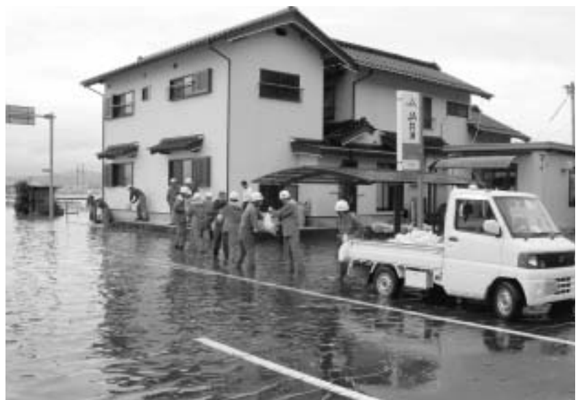
懸命の水防作業(園町沖ノ島地区)
