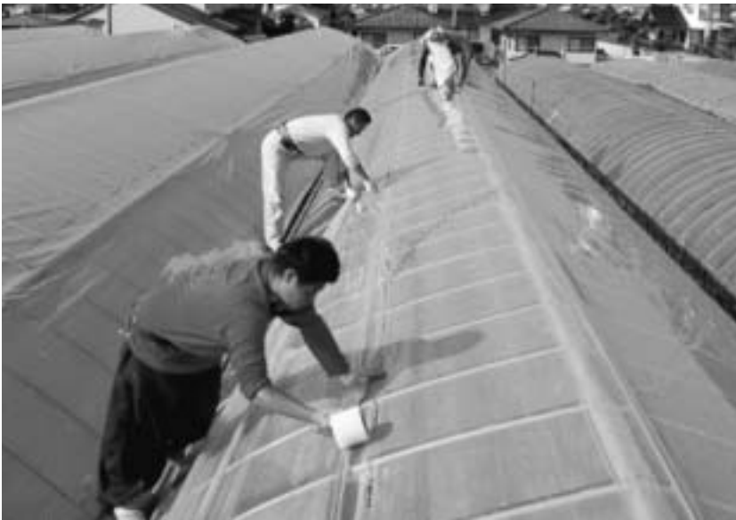
ぶどうハウスのビニール張り作業
