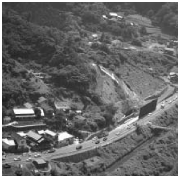
全面通行止めとなった国道9号(多伎町)
