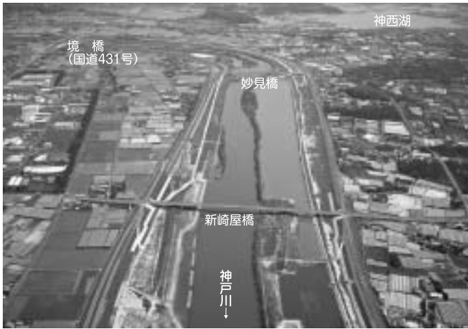
順調に進む斐伊川放水路事業 (写真は神戸川拡幅部)
