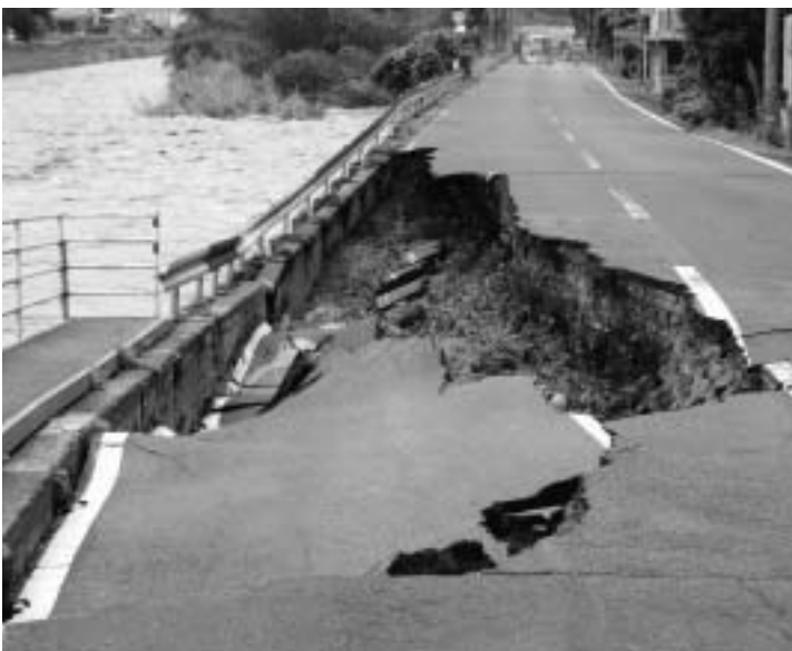
災害の凄まじさを物語る国道184号の陥没現場(佐田町地内)
