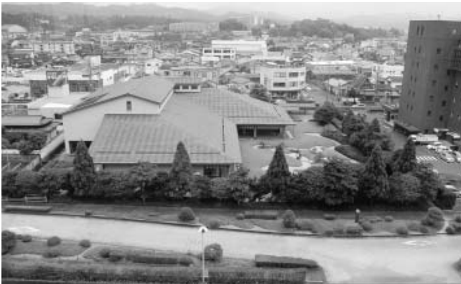
駐車場の不足が指摘される中央図書館
