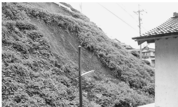
▲急傾斜地の崩落（小伊津町）
