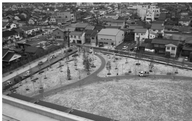
整備中のだんだん広場
