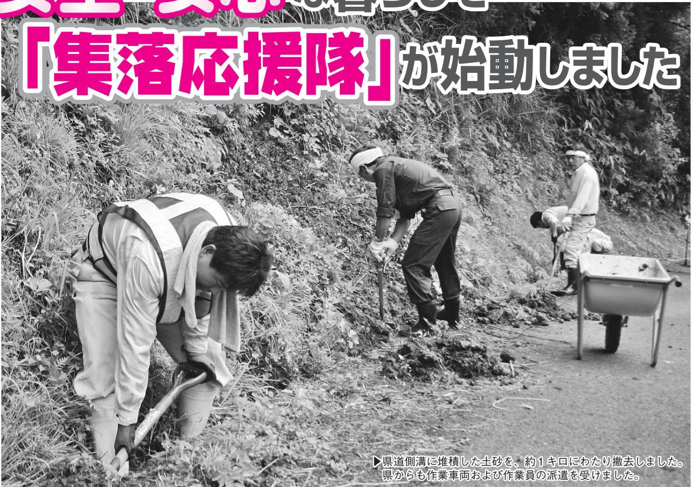
▶ 県道側溝に堆積した土砂を、約1キロにわたり撤去しました。県からも作業車両および作業員の派遣を受けました。
