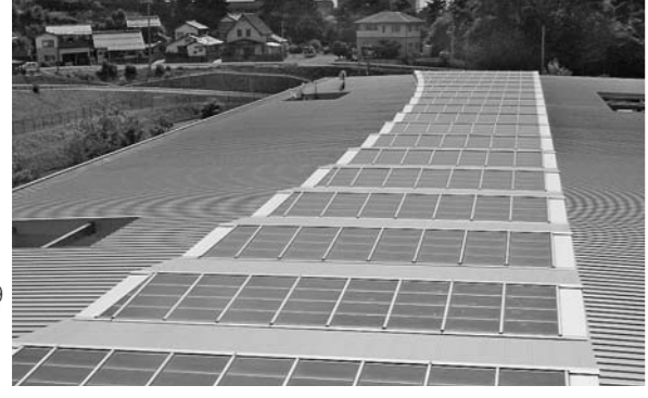
▶市役所本庁舎屋上設置型出力70.0kW 市役所の1フロア一分の照明をまかなう発電能力があります。
